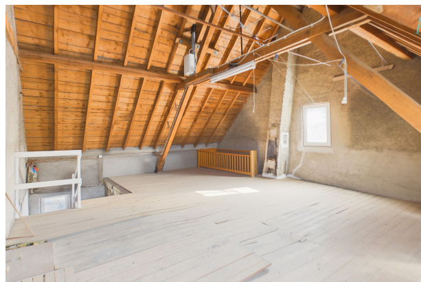
Dachboden (mit KI aufgeräumt)
